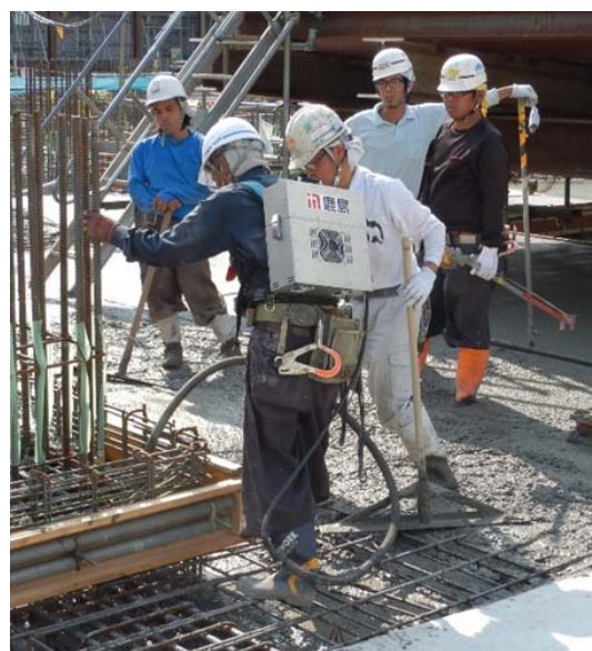
写真－4 バッテリー式ウェアラブルバイブレータの試適用状況
