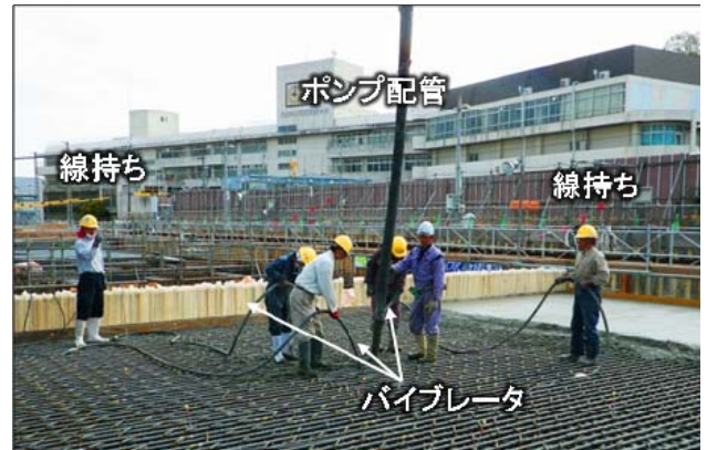
写真－1 従来の一般的な締固め作業
