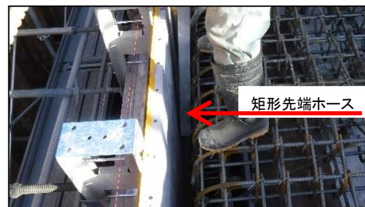
写真-3 先端ホースのかぶり部への挿入状況
