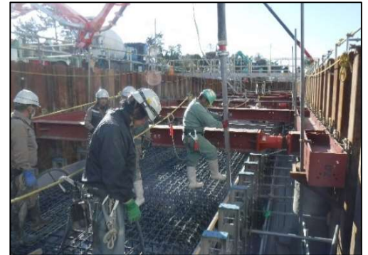
写真-1 開発した先端ホースによる施工状況
