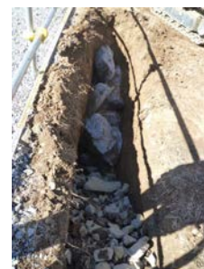
写真-6 捨石状況
