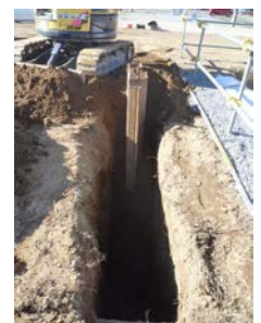
写真-7 鋼矢板状況
