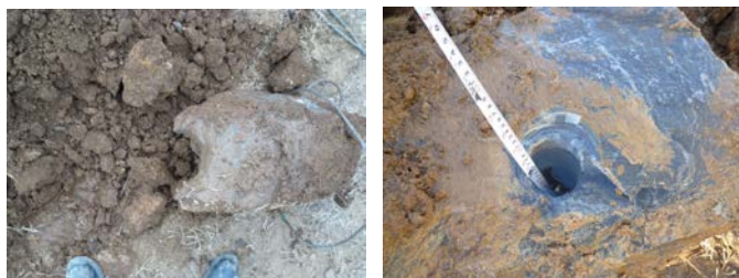
写真-7 捨石削孔
