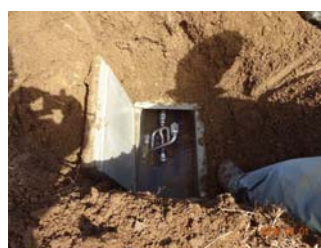
写真-5 ノズル配置状況
