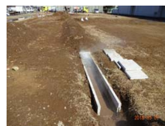
写真-6 ウォータージェット噴射状況
