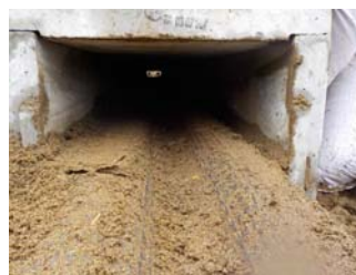
写真-7 砂除去後のトラフ内状況(バキューム)
