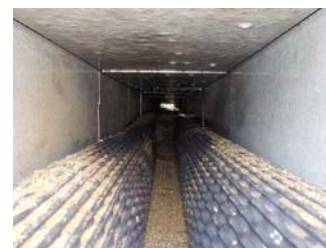
写真-8 砂除去後のトラフ内状況(ウォータージェット)
