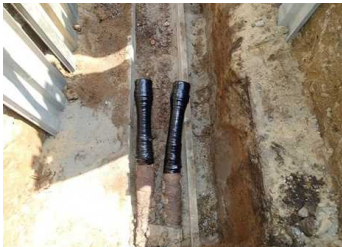
写真-1.2 地中送電ケーブルおよびコンクリートトラフ
