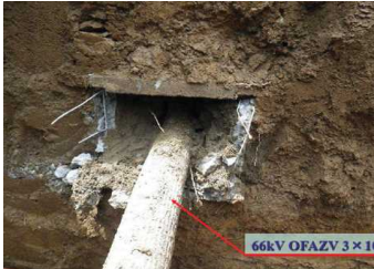
写真-1.2 地中送電ケーブルおよびコンクリートトラフ
