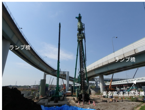
写真-1 施工時の状況
