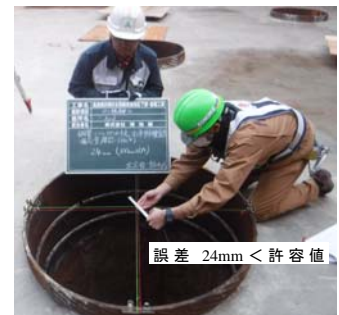
写真-2 出来形測定状況
