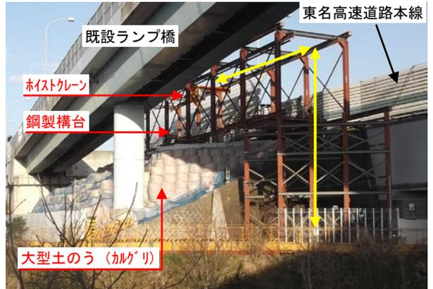
写真-2 揚重用鋼製構台
