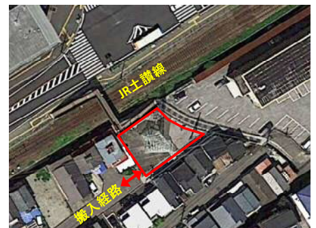
写真-1 施工箇所(No.54)
