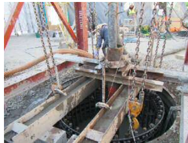
写真-4 コンクリート打設
