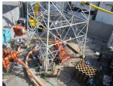
写真-2 掘削状況
