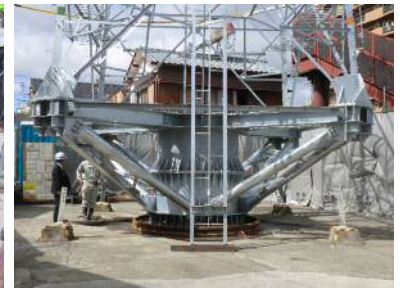
写真-5 鋼製フレーム
