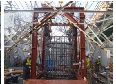
写真-3 鉄筋かご建込み
