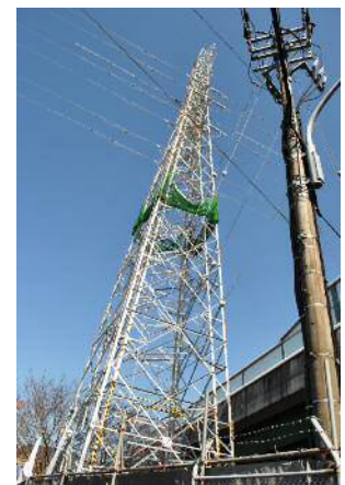
写真-6 鉄塔包込み
