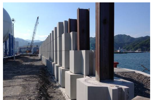
図 7 鋼管杭圧入後、プレキャストブロック設置
