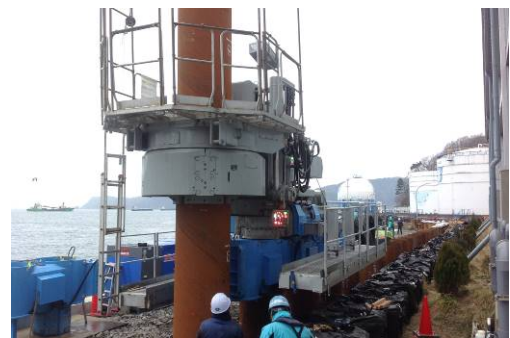
図 6 鋼管杭圧入中
