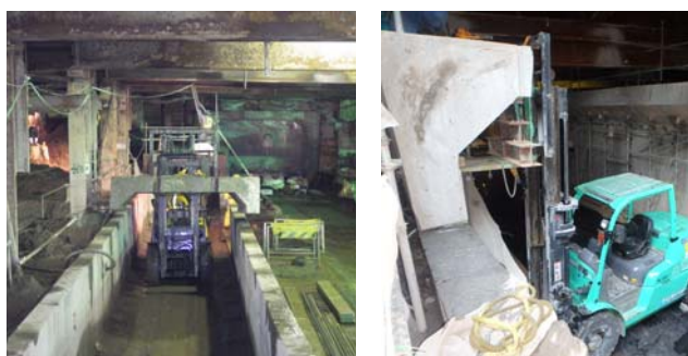
写真2 雨水函渠撤去時
