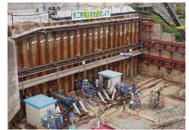
写真 3. 施工状況 (全景)
