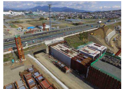
写真 1. 函体推進状況 (SFT 工法)
