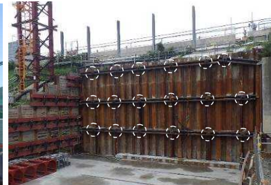
写真 7. 施工完了 (到達立坑側)
