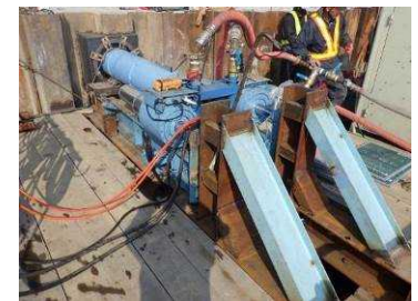
写真 4. 施工状況 (近景)
