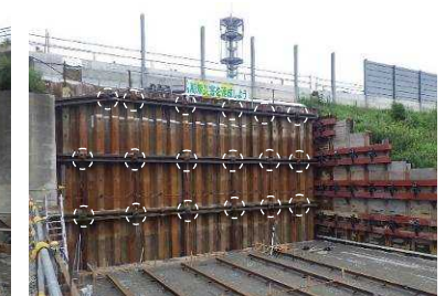
写真 8. 施工完了 (発進立坑側)
