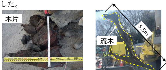
写真-1 出土した木片および流木
