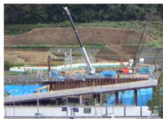
写真-1 施工全景
