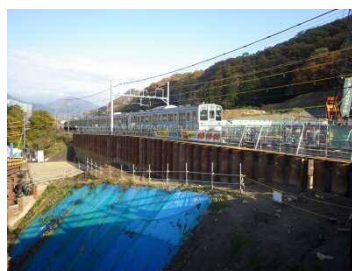
写真-6 鋼管杭圧入完了
