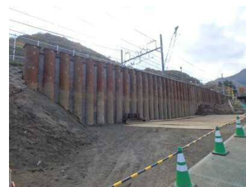
写真-6 鋼管杭圧入完了
