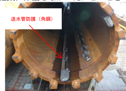
写真-5 送水管防護
