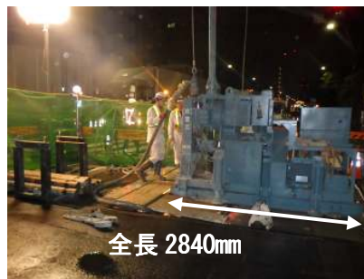
写真-2 BH工法の施工状況と4種類の先端ビット
