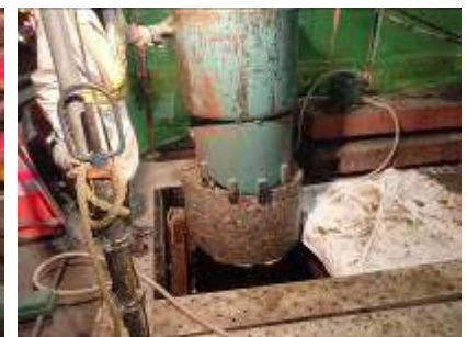
写真-3 クラムバケットと障害の撤去状況
