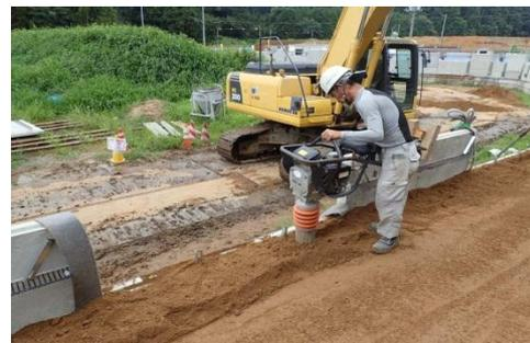
図-5 ベントナイト混合土 転圧・締固め状況
