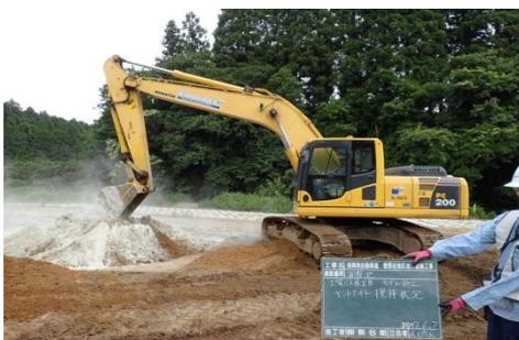
図-4 ベントナイト混合土 攪拌状況
