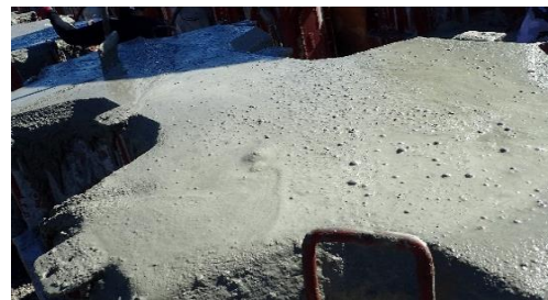
図2 消波根固ブロックの打設状況
