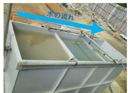
図8 放流側ノッチタンクの状況
