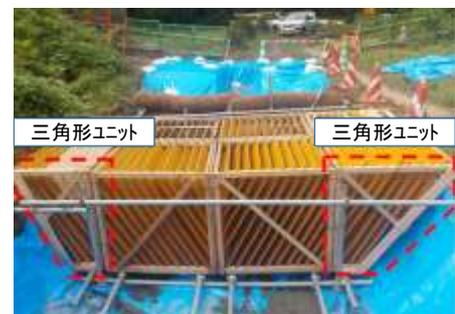
写真-4 傾斜板の両端部
