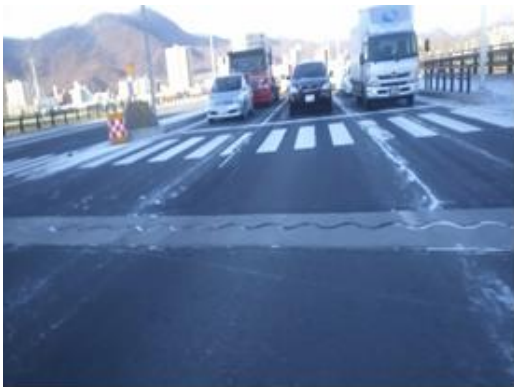
写真2 橋梁本体部材経年供用状況(札幌市南十九条橋)
