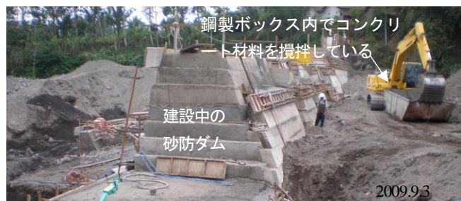
図2 ダムサイトで採取した骨材と水及びセメントを鋼製ボックスの中に投入し、油圧ショベルで攪拌して砂防コンクリートを製造した(メラピ火山緊急防災)。
