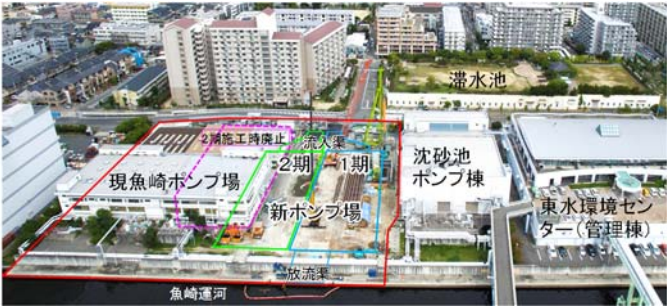
写真1 魚崎ポンプ場全景、全体計画概要
