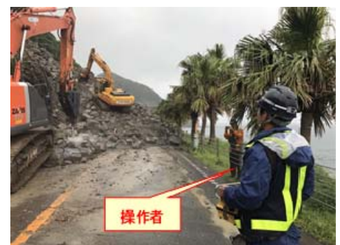
写真-2 無人化施工訓練受講者による無人化施工状況
