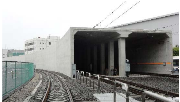
写真-1 模擬トンネル全景
