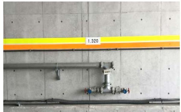
写真-2 変状の無い模擬トンネル壁面
