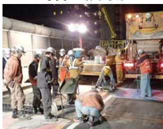
写真-5 コンクリート打設状況
