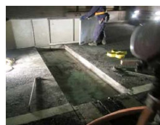
写真-2 伸縮装置撤去完了
