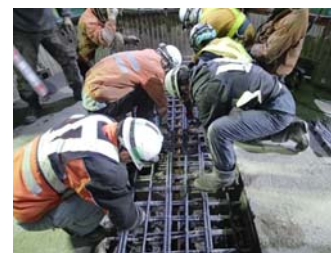
写真-4 鉄筋組立状況
