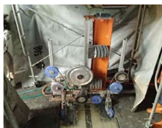
写真-1 ワイヤーソー設置
