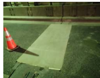
写真-6 施工完了
