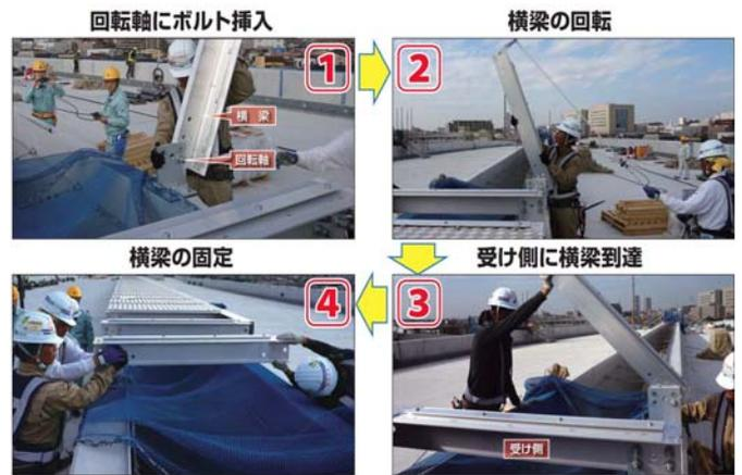
写真3 横梁の施工フロー
