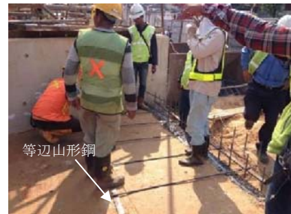
写真 4 型枠用アンカー設置
