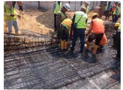
写真 1 ジオテキスタイル敷設
