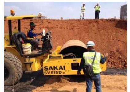
写真 3 盛土材料締固め
