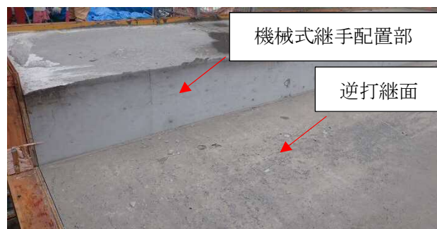
写真-4 コンクリートの充填状況
