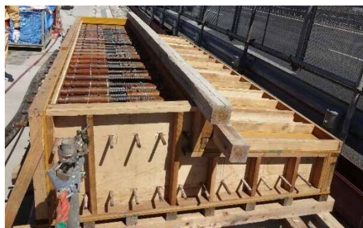
写真-1 実物大モックアップ供試体（L=3.6m）
