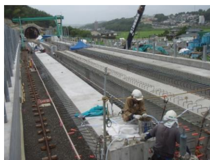
写真-5 グラウト注入状況
