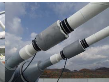
写真-5 センサー取付状況
