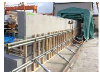
写真-1 供試体全景
