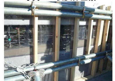
写真-2 モルタル充填状況
