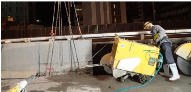
写真-1 高欄吊り切り状況
