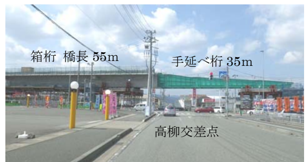
写真-1 押出し架設状況
