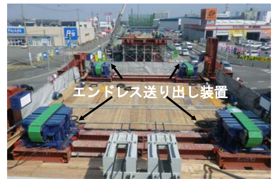
写真-5 仮支柱上のエンドレス送り出し装置
