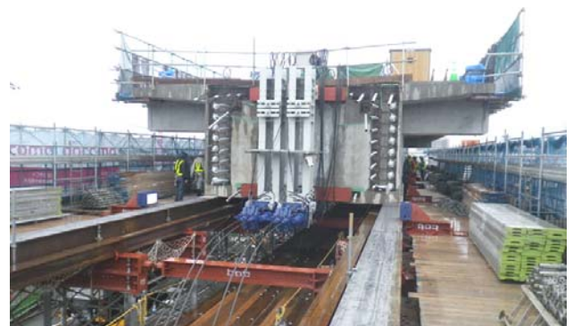
写真-2 主桁押出し架設状況
