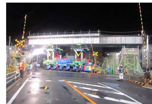
写真-2 多軸台車による桁の運搬架設状況
