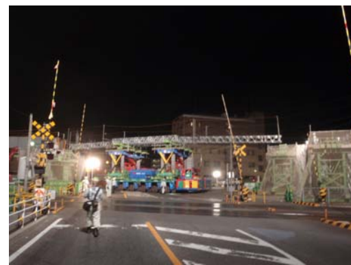
写真-1 足場材を桁に見立てたリハーサル状況
