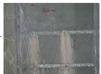
図-3 漏水状況
