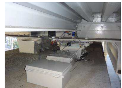
図 2. モニタリングシステム設置状況
