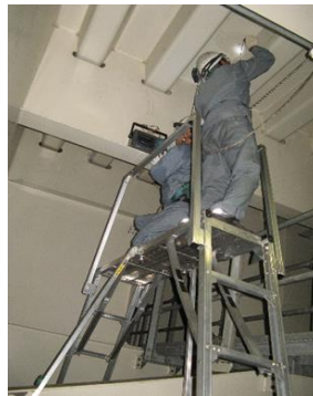
図-2 Uリブ超音波探傷状況
