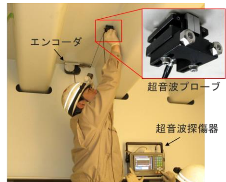
図-3 鋼床版 SAUT 調査状況
