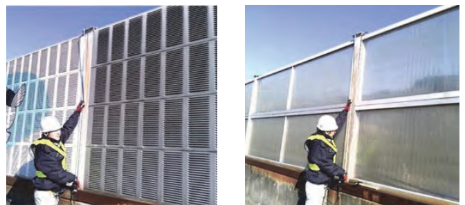
図3 通常遮音板（左）及び透明遮音板（右）
