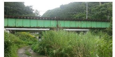
図3 対象橋りょう外観
