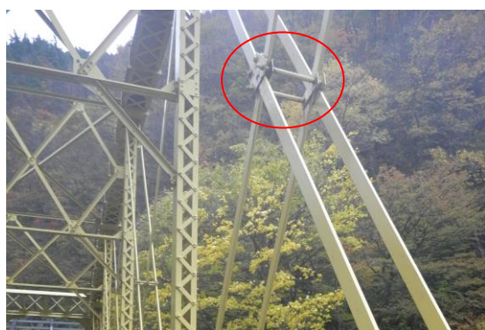
図5 中央格間交差部のブレ止め
