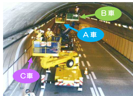
図-3 現状のトンネル点検作業状況
