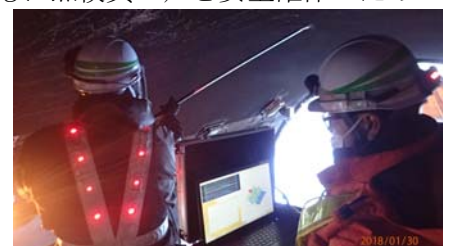
(図-3 現地検証状況)
