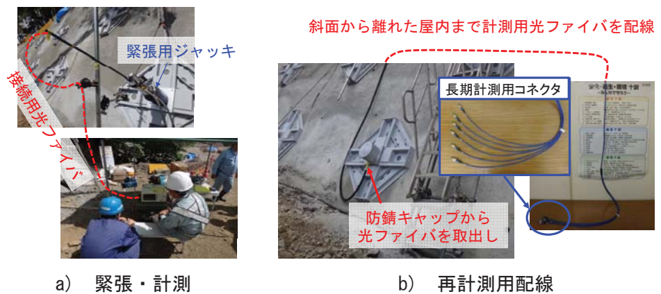
写真-1 施工状況
