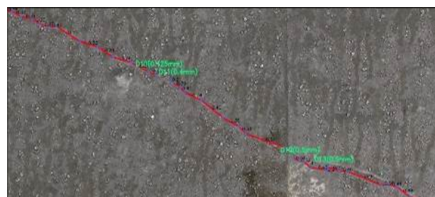
写真-4 覆工コンクリート(一眼レフ C)
