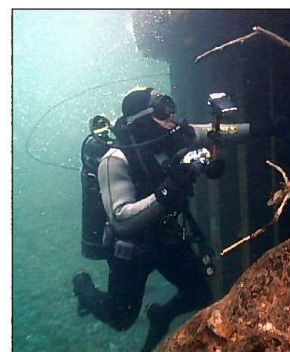
図-2 ダイバーによる潜水調査
