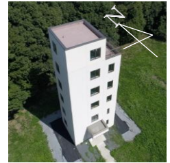
図1 6階建て実大実験棟外観(ドローンによる撮影)
