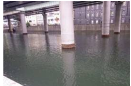
写真 1 河川内の鋼橋脚
