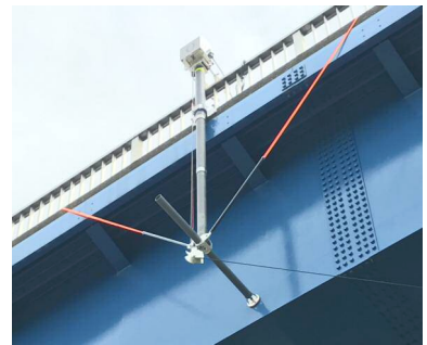
図 1 支持ロッドの取り付け状況
