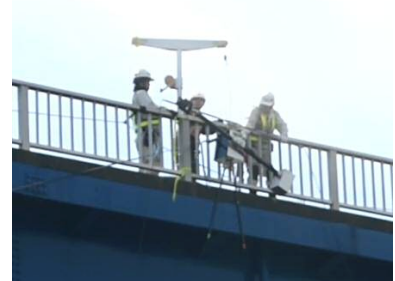
図 4 橋面からの吊り降ろし状況
