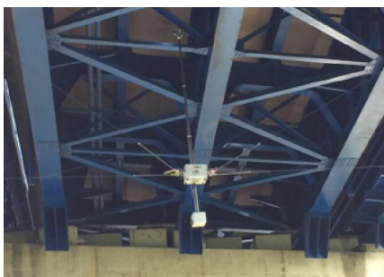
図 7 格間に伸展し床版に近接
