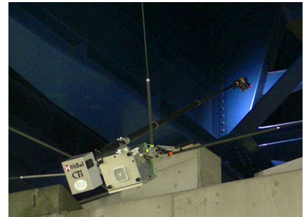
図 9 支承周辺の点検
