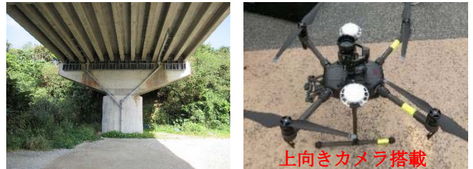
図-1 点検対象の外観と撮影に用いた UAV
