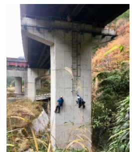
図-6 ロープ高所作業状況
