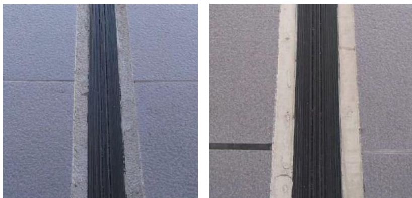
図 7 現場施工結果（左：材料 A（骨材あり），右：材料 B（骨材なし））
